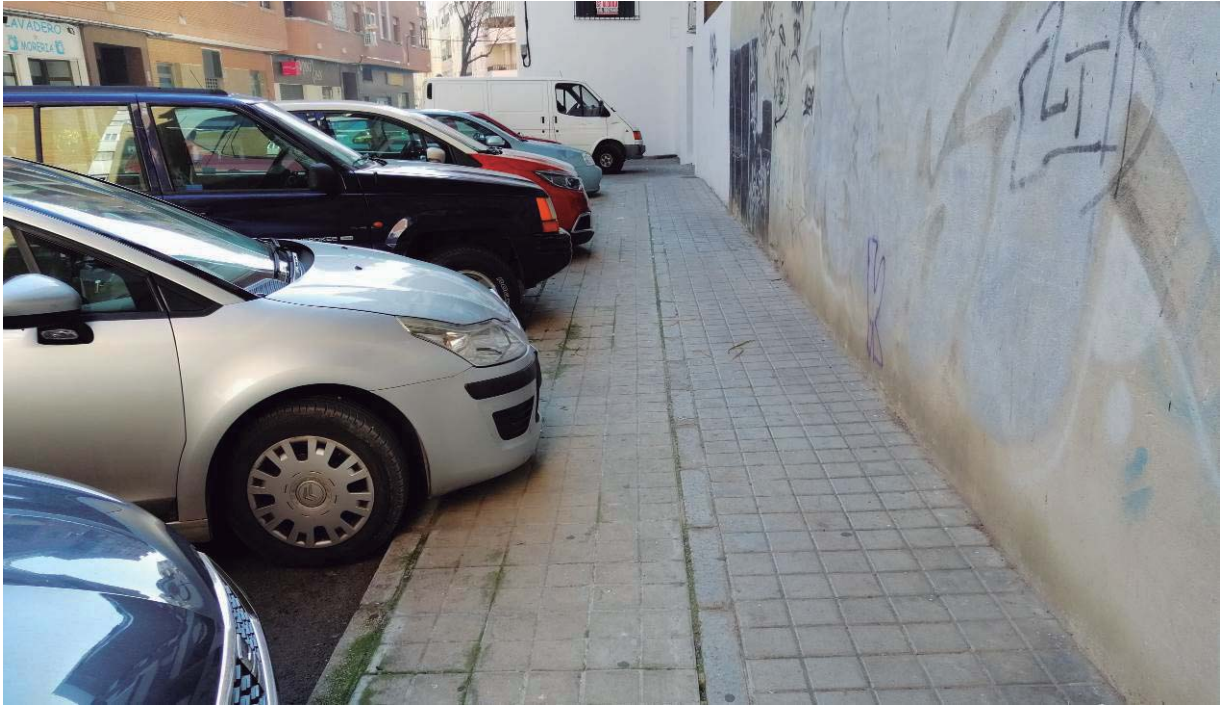
Ampliación de acerado con existencia de doble bordillo. Solado en mal estado
