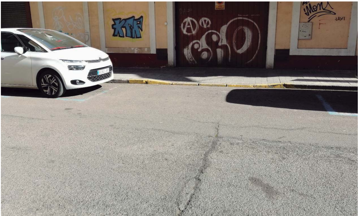
Pavimento en mal estado. Importante pendiente de vado en el acerado.
