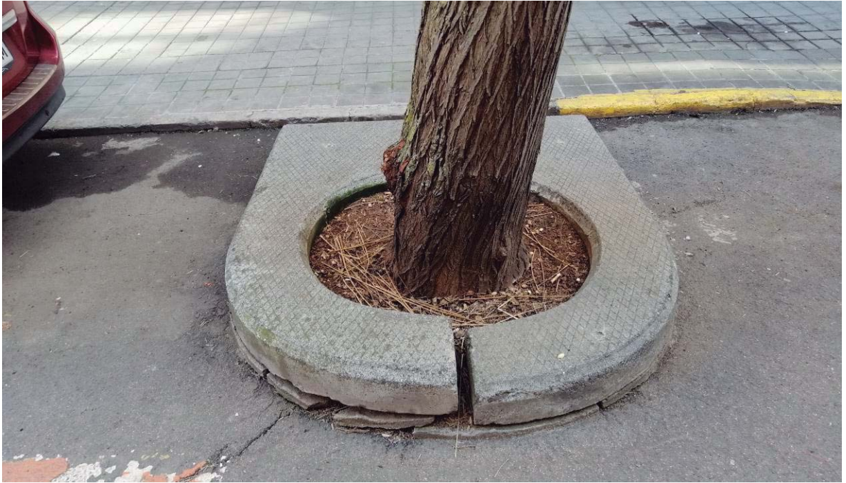
Alcorques en mal estado. Fisuras y abombamientos en el asfaltado. Bordillos semienterrados.
