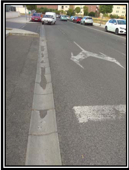
Foto 18. Canaleta a fresar
