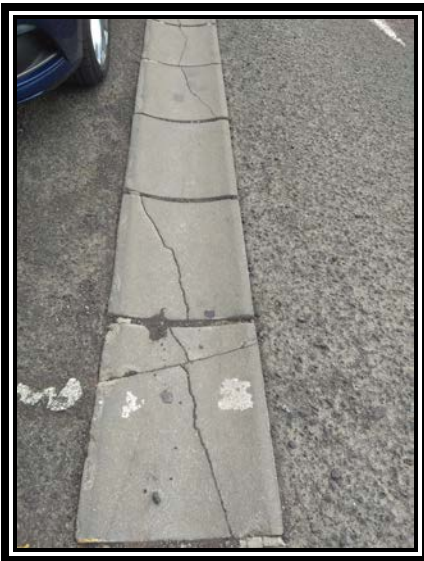
Foto 10. Canaleta en C/ Torrenueva. T. derecha
