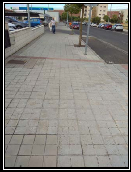
Foto 8. Acerado en C/ Torrenueva
