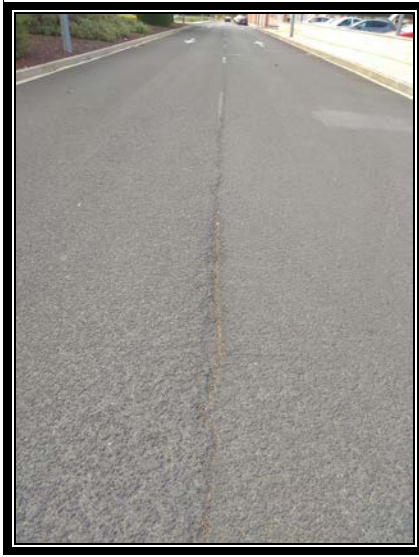
Foto 14. Fisura longitudinal
