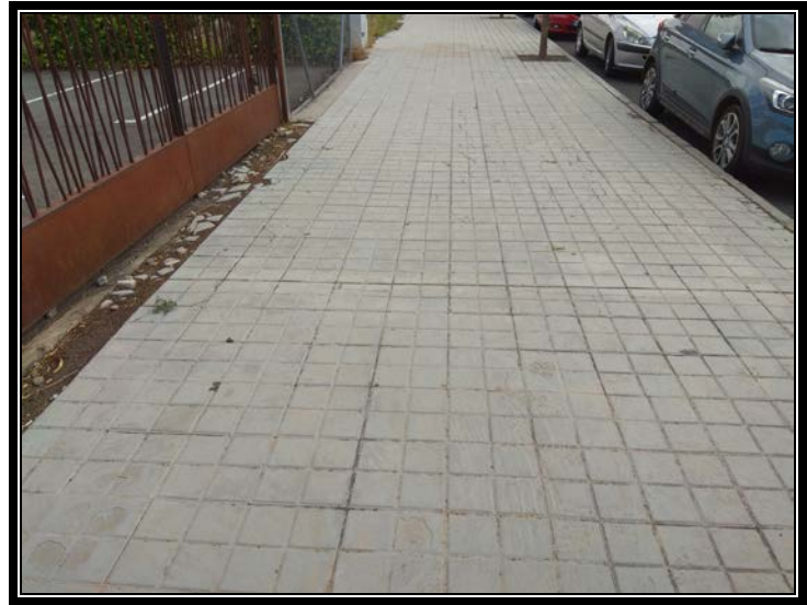
Foto 9. Acerado en C/ Torrenueva con parcela Ayto.
